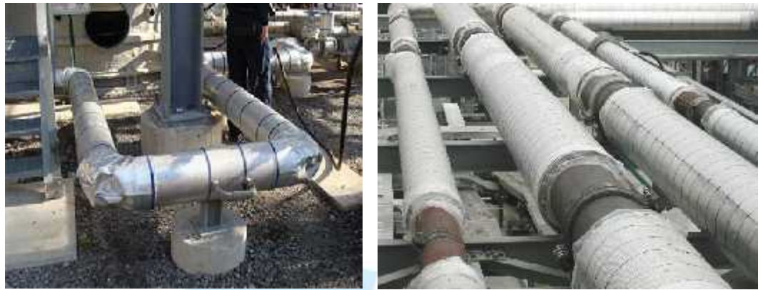
Gambar 30. Perbaikan kerusakan insulator
